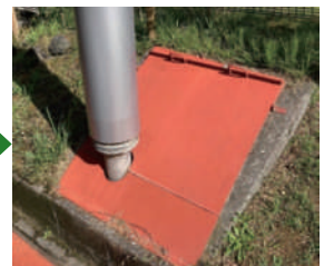
(改善後) 配管外に吸音・遮音材を設置 また、騒音発生部にカバーを設置
