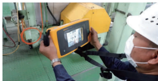
エアリー漏れ箇所の確認の様子
